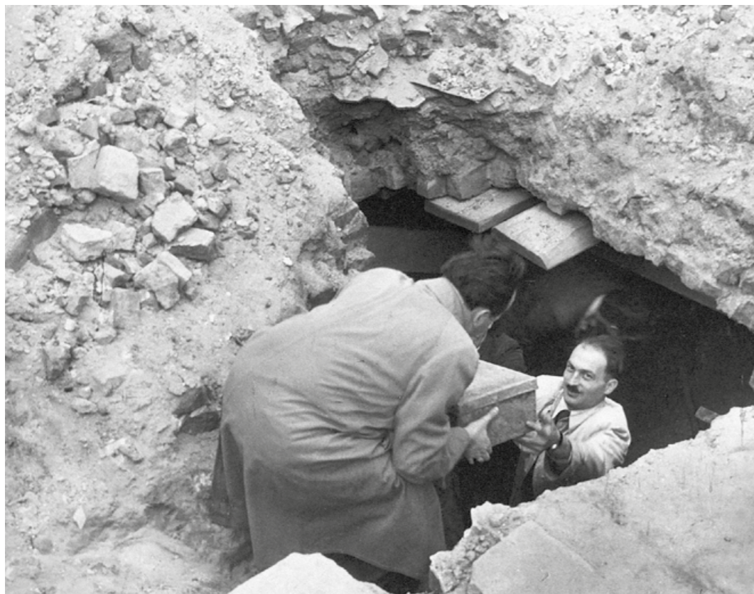
↑ Wydobycie pierwszej części Archiwum spod gruzów getta. Widoczni na zdjęciu: Michał Borwicz i Hersz Wasser
